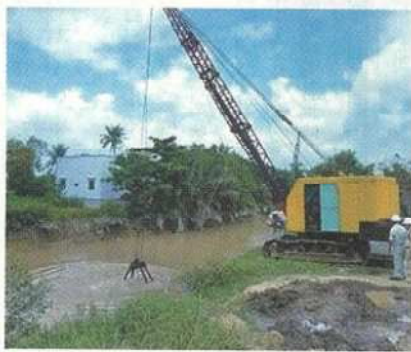
現地適合試験でチョーガオ運河から土砂を採取
