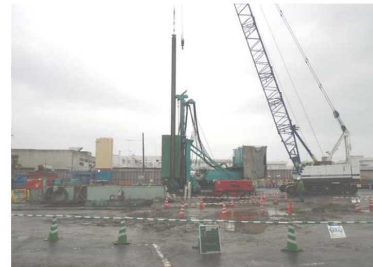
施工状況全景
