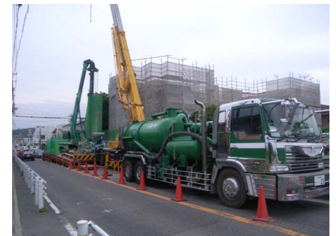
施工状況全景
