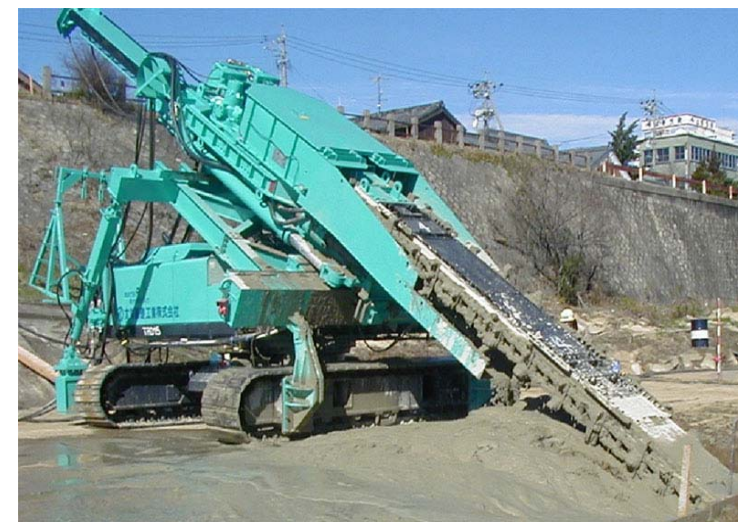
掘削造成状況
