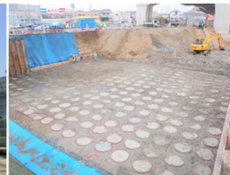
改良杭出来形
